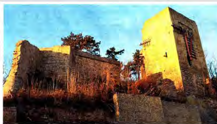
Die Sanierungsarbeiten an der Burg sollen 2018 weitergehen. Derzeit schützen Klammern die Bau-substanz am Palas.
